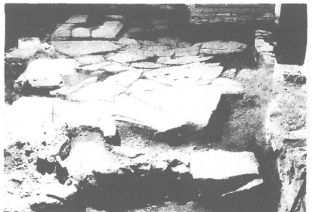
Abb. 9: Eckenbagen nördliches Seitenschiff mit Platten und Sockel der romanischen Anlage von Osten
